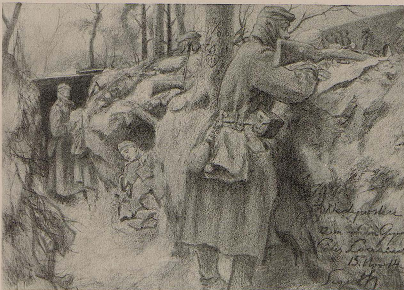
12 Meter von dem Gegner (Côtes Lorraines)
